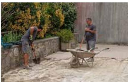
Suite aux dégradations prématurées des marches de l'école (2019) du fait d'une malfaçon et avec l'aval de notre assureur (garantie décennale), les marches vont être réhabilitées.
